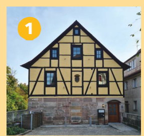
vhs Geschäftsstelle Stein Untere Wassergasse 3
