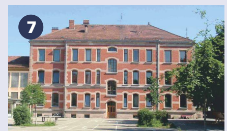
Grundschule Mühlstraße, Mühlstr. 29
